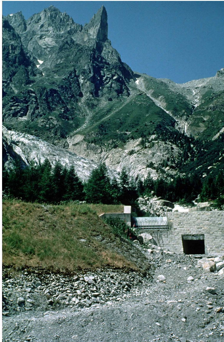
Abbildung 2: Sanierte Wasserfassung mit Hochwasserüberlaufwerk am Glacier de Saleina (Foto H. Röthlisberger, 1983).
